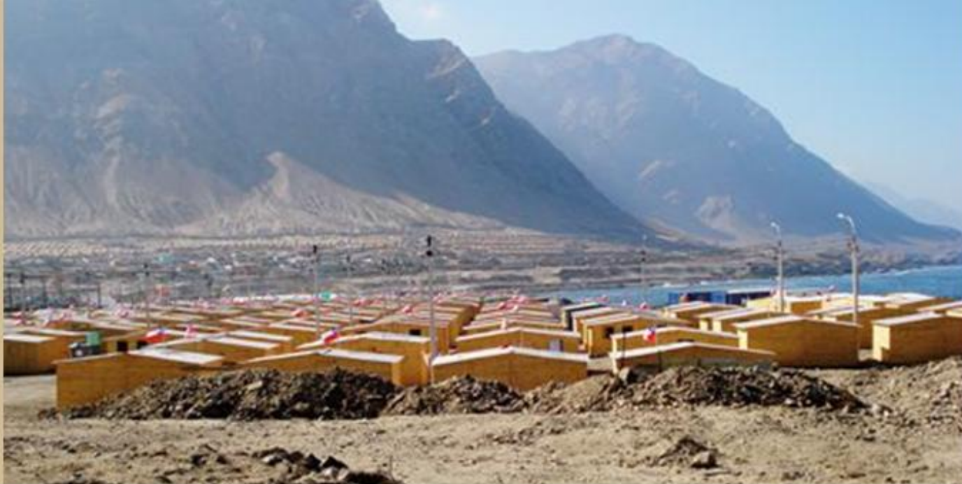
Vista panorámica de uno de los 13 barrios de emergencia construidos en la comuna de Tocopilla. Estos cuentan con servicios de luz, agua potable, servicios higiénicos y duchas.
