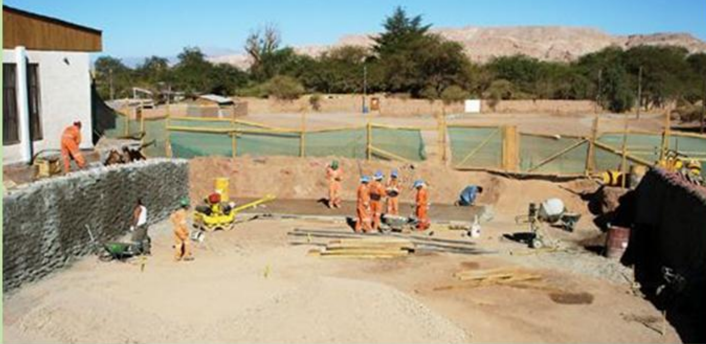
Trabajos de construcción de la nueva piscina techada de la comuna de San Pedro de Atacama.
