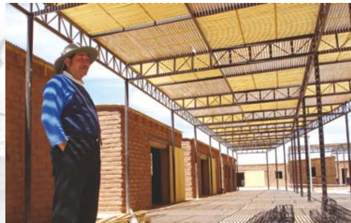
En el nuevo pueblo de Artesanos de San Pedro de Atacama destaca su bella arquitectura y la utilización de materiales típicos de la zona.
