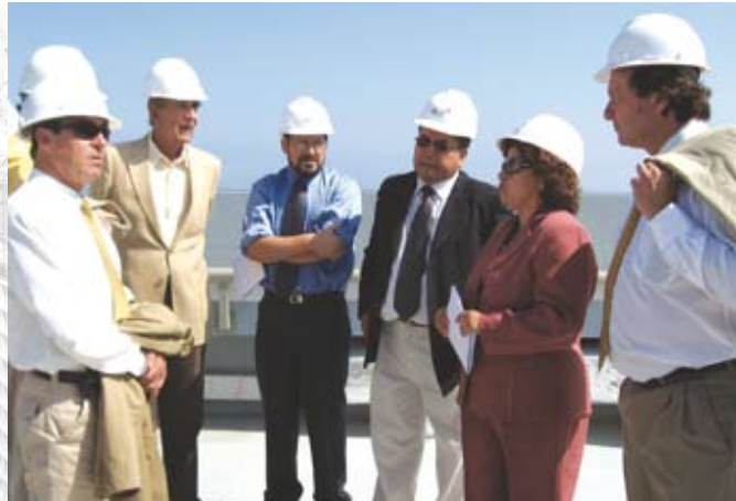
Visita de los Consejeros Regionales de la Comisión de Obras Públicas, Vivienda y Transporte a los trabajos de reparación y construcción del nuevo cuartel de Investigaciones.
